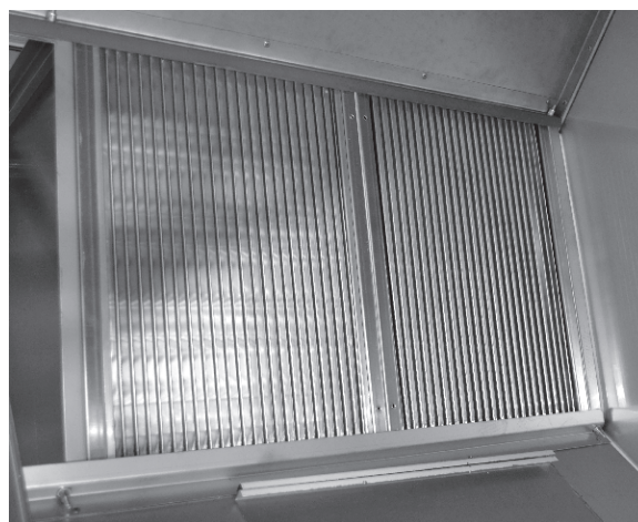
Рисунок 11. Пластинчатый рекуператор
